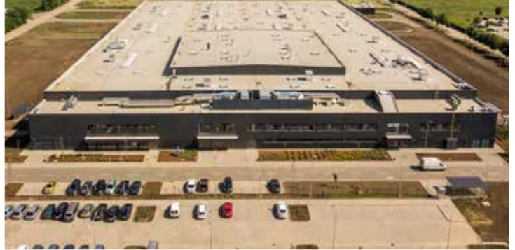
Thyssenkrupp Components Technology Hungary gyártóüzem, Debrecen
