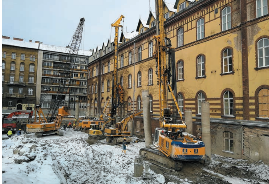
A munkatér-határolás több mint 315 darab 88 centiméter átmérőjű cölöp segítségével készült el.
