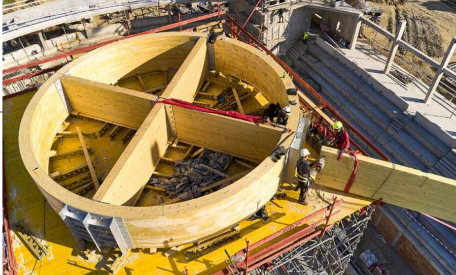
30 méteres főtartó összeszerelése a 8 méter átmérőjű opeionnal
