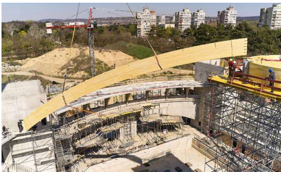
30 méteres főtartó összeszerelése a 8 méter átmérőjű opeionnal
